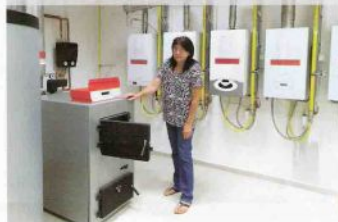
„Všetky zariadenia v učebni sú pine funkčné, všetky kotly, vrátane tohto drevosplyňovaciaho, sú vyvedené do komína, aby si ich žiaci mohli otestovať v reálnej prevádzke,“ vysvetľuje zástupkyňa riaditeľky školy Iveta Bakíčová.
